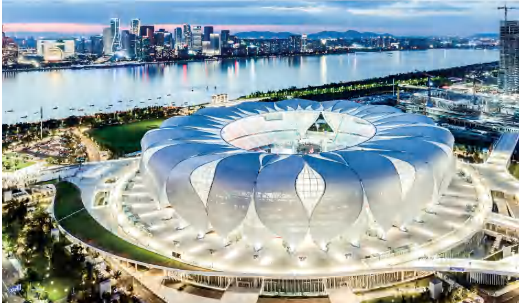
音王承担了近八成新建亚运场馆的音响设备提供、安装、技术支持和调试等服务
