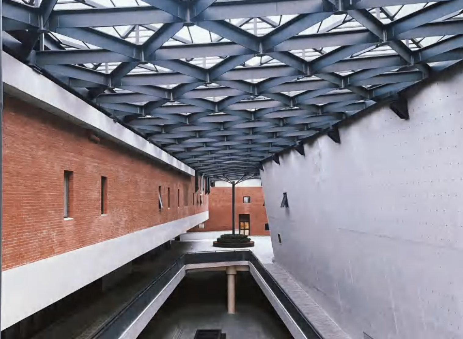
如今的奉化博物馆最大限度地保留并重现奉化热电厂建筑的原有风貌
